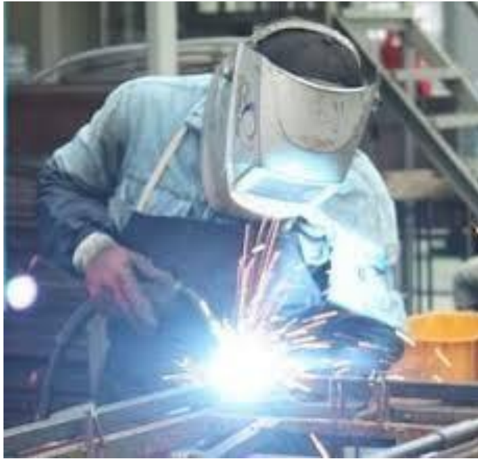
Fabricación de andamios
